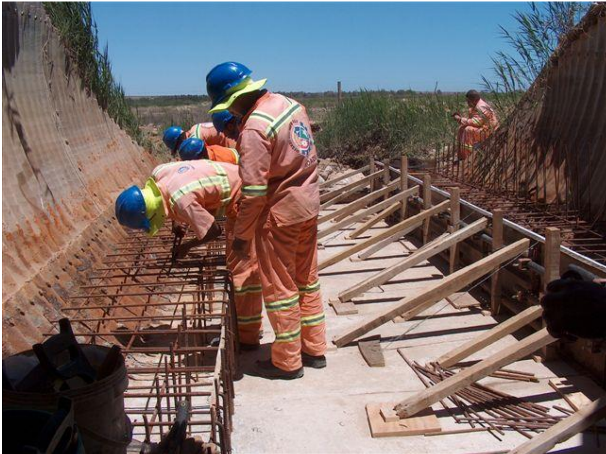
Rehabilitasie van Amco strukture te Afdelingspad 2224 (Koekenaap omgewing)
